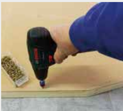
1. Bodenplatten anschrauben
